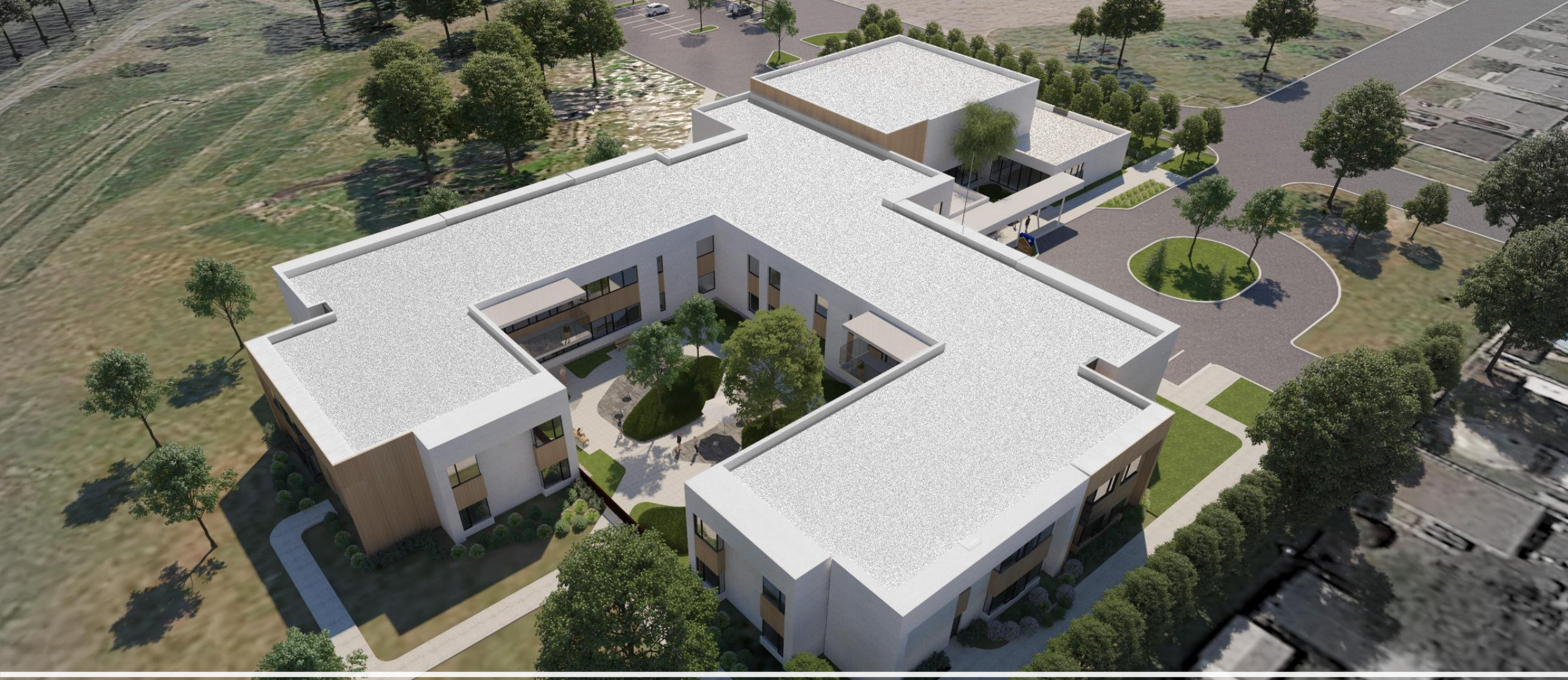
Maison des aînés de Sainte-Anne-des-Plaines - Vue aérienne
